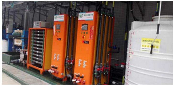
图 6-5 VF 微滤系统设备展示图
