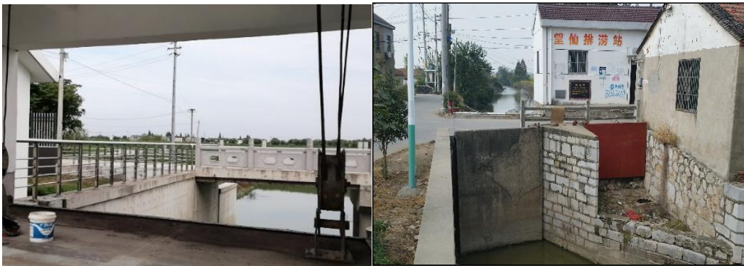
图 1.5-2 建丰枢纽、望仙闸
