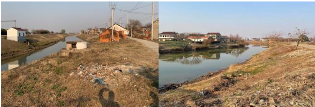
图 2.2-2 岸线侵占现象
